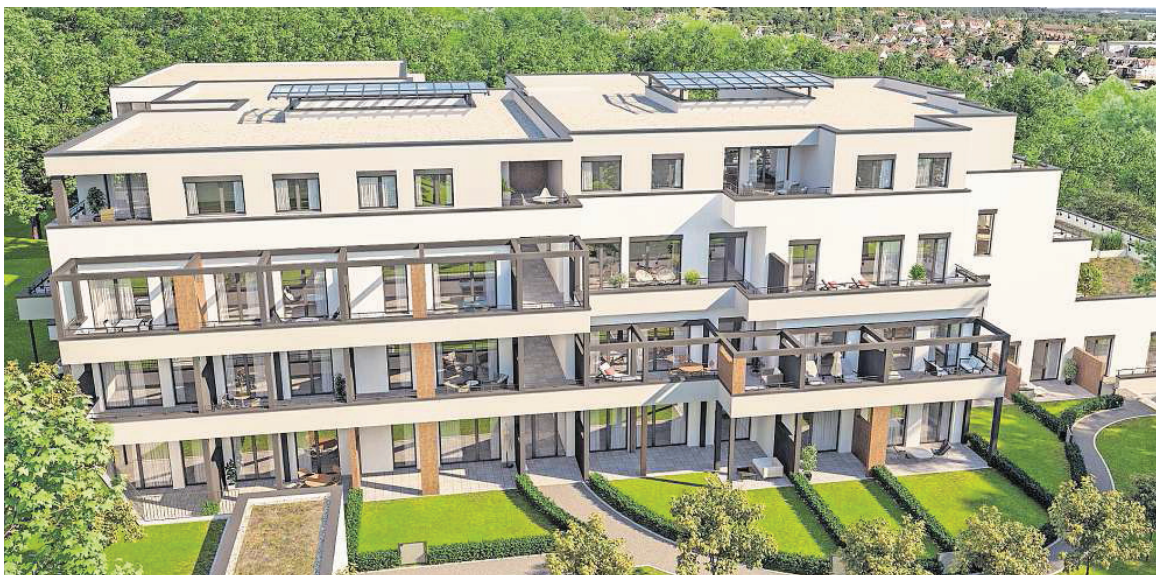
Aus dem alten DSZ wird eine attraktive Wohnimmobilie. Ende 2018 will die Firma projektbauart mit der Sanierung des Hauptgebäudes beginnen.
