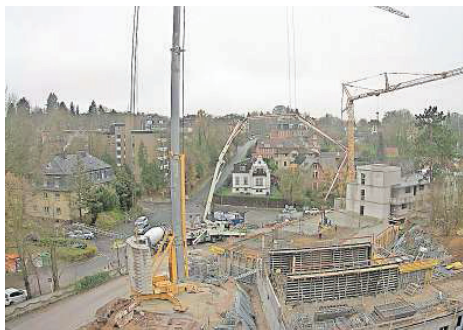
Auf der Baustelle an der Leopoldstraße geht es voran. Der Bauabschnitt I (im Hintergrund) ist im Rohbau fertig. Bei Bauabschnitt II werden gerade Decken betoniert.
